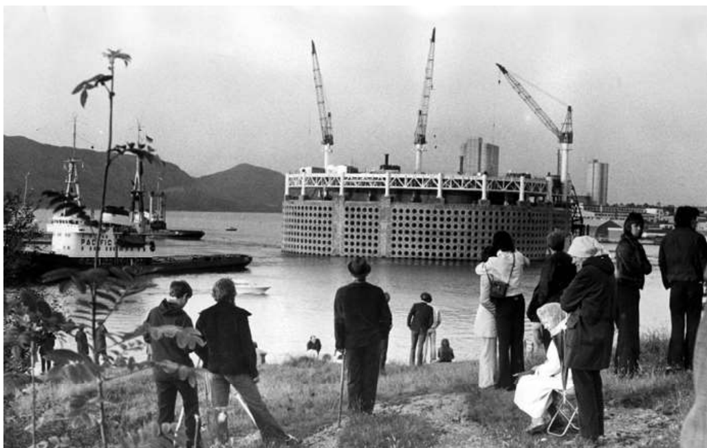
Ekofisktanken taues ut i 1973. Plattformen er blitt kalt en norsk ingeniørbragd – særlig på grunn av bruken av betong.
